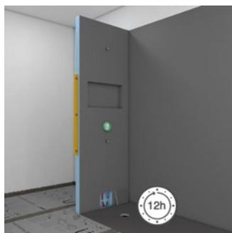
Aligner la cloison modulaire à l'aide d'un niveau à bulle.
